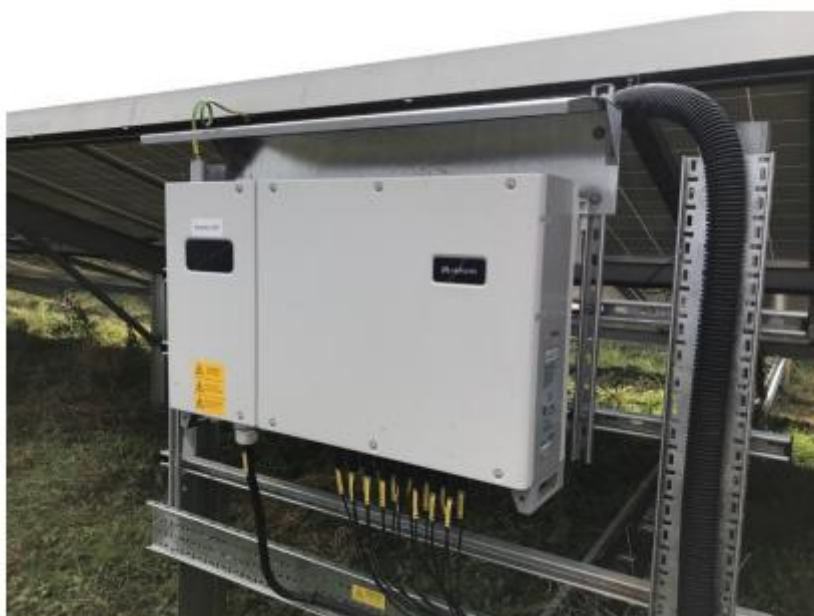
Slika 2.5 Primjer montaže izmjenjivača niza (Izvor: Idejno rješenje)
